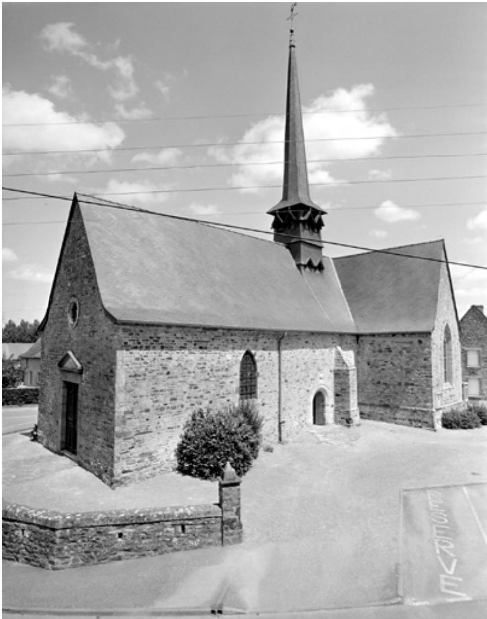
Eglise Saint-Pierre : élévation sud-ouest
