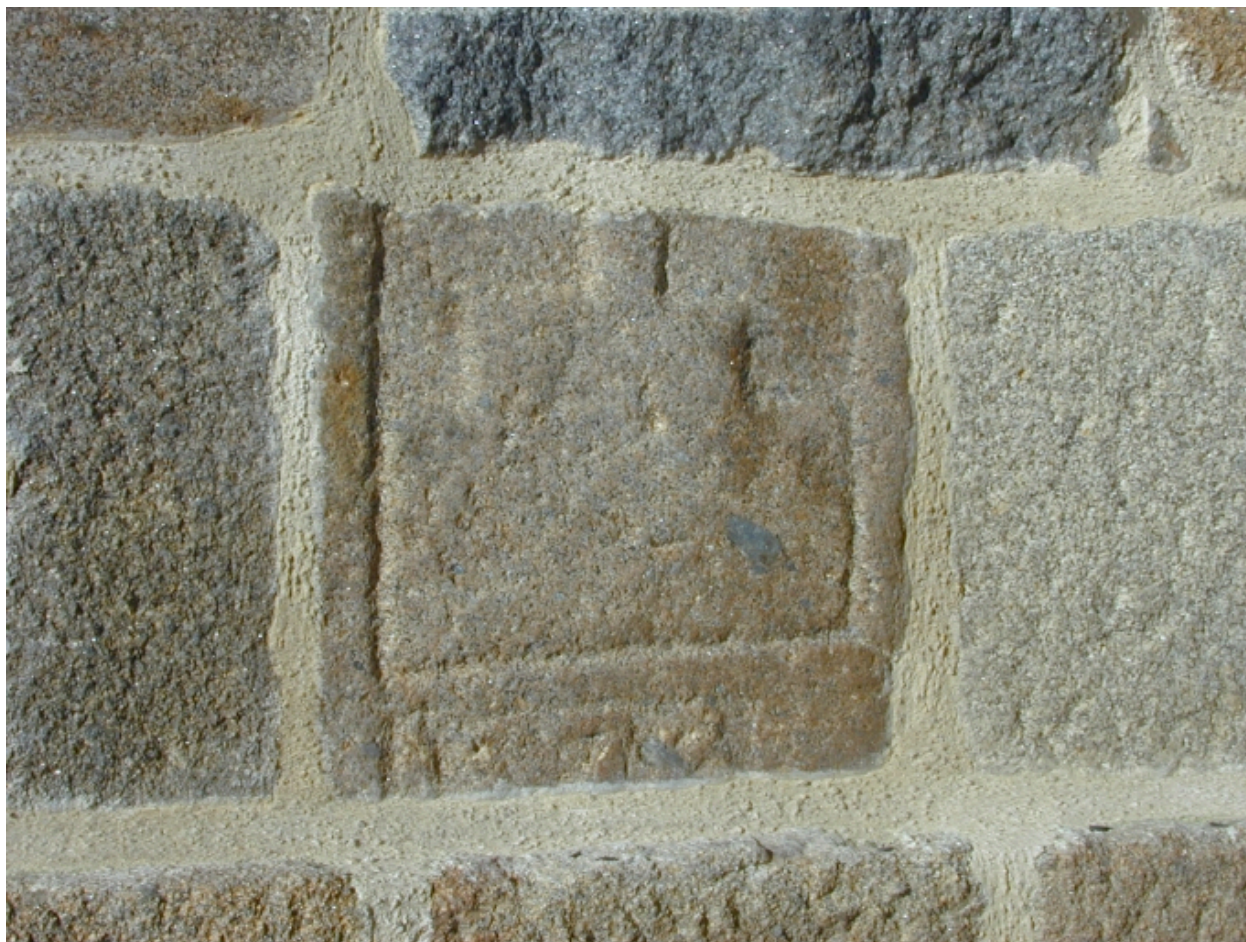
Sacristie, pierre tombale réemployée dans le mur oriental : détail
