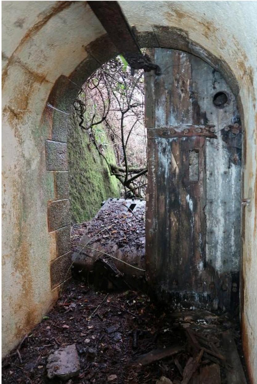
Vue de l'entrée depuis l'intérieur : battant de porte en bois doublé à l'extérieur d'une plaque métallique. Suspendu au plafond, le rail pour la manutention des obus via le treuil manuel à tambour
