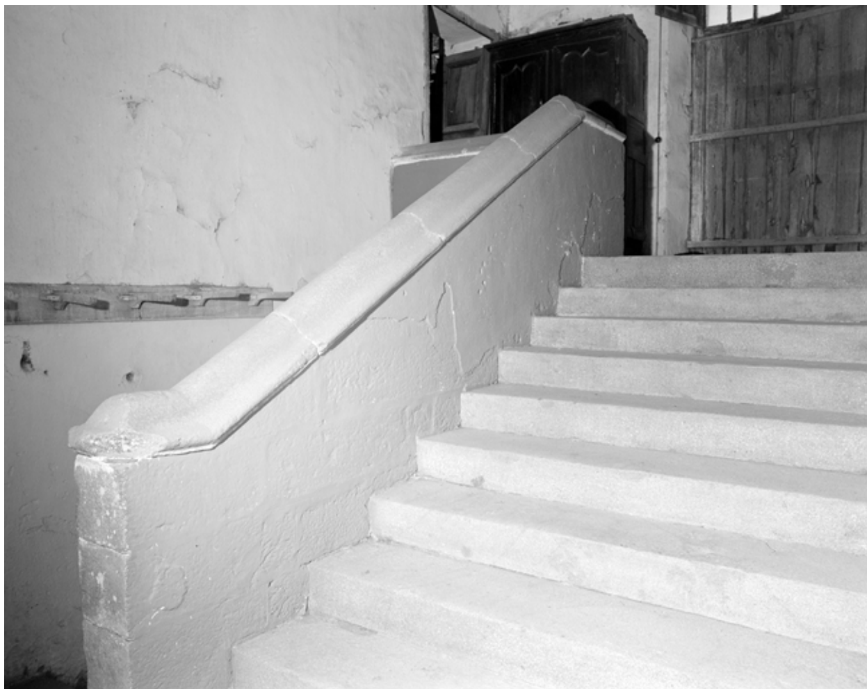
Escalier principal, premier palier
