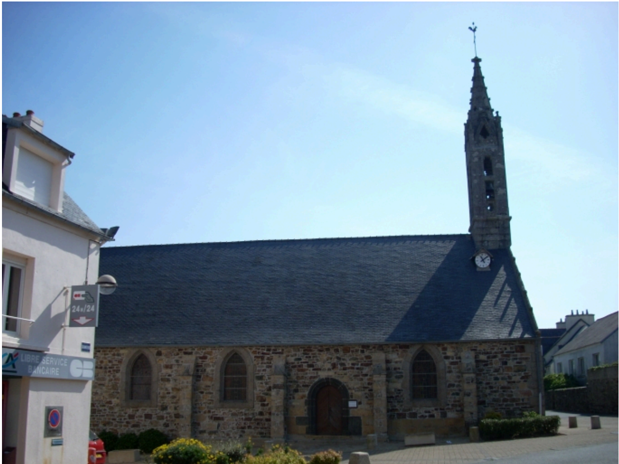
Lanvéoc, église paroissiale : vue générale nord-ouest
