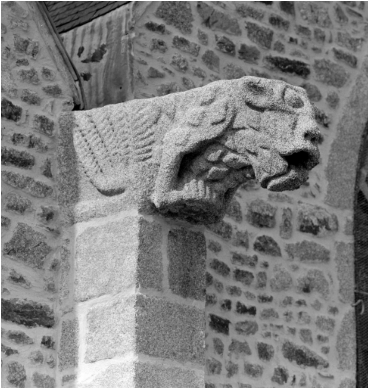
Élévation Nord, gargouille : détail de la face Est
