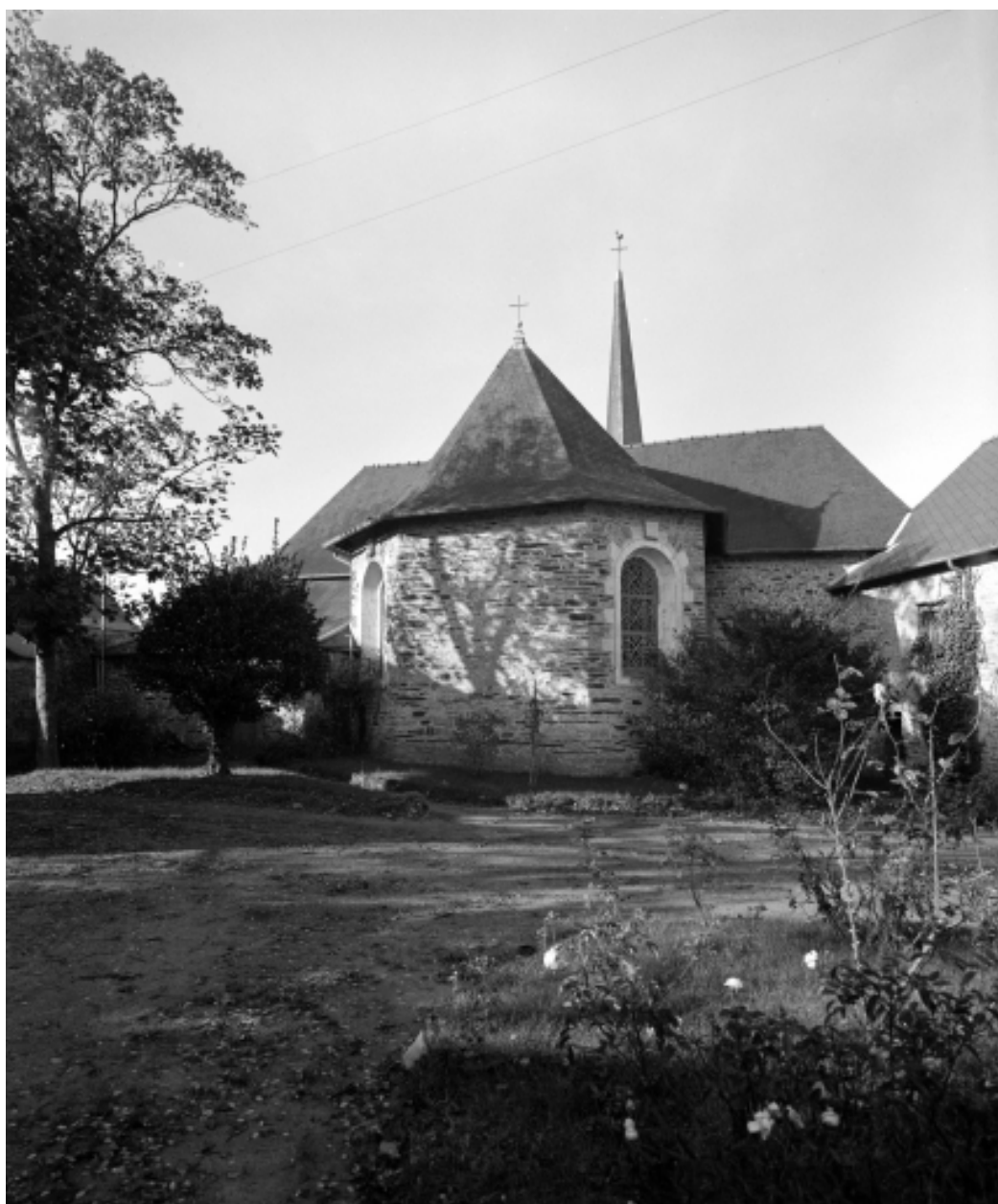
Elévation Est : vue générale
