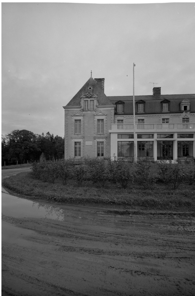
Elévation ouest : pavillon nord, vue générale.
