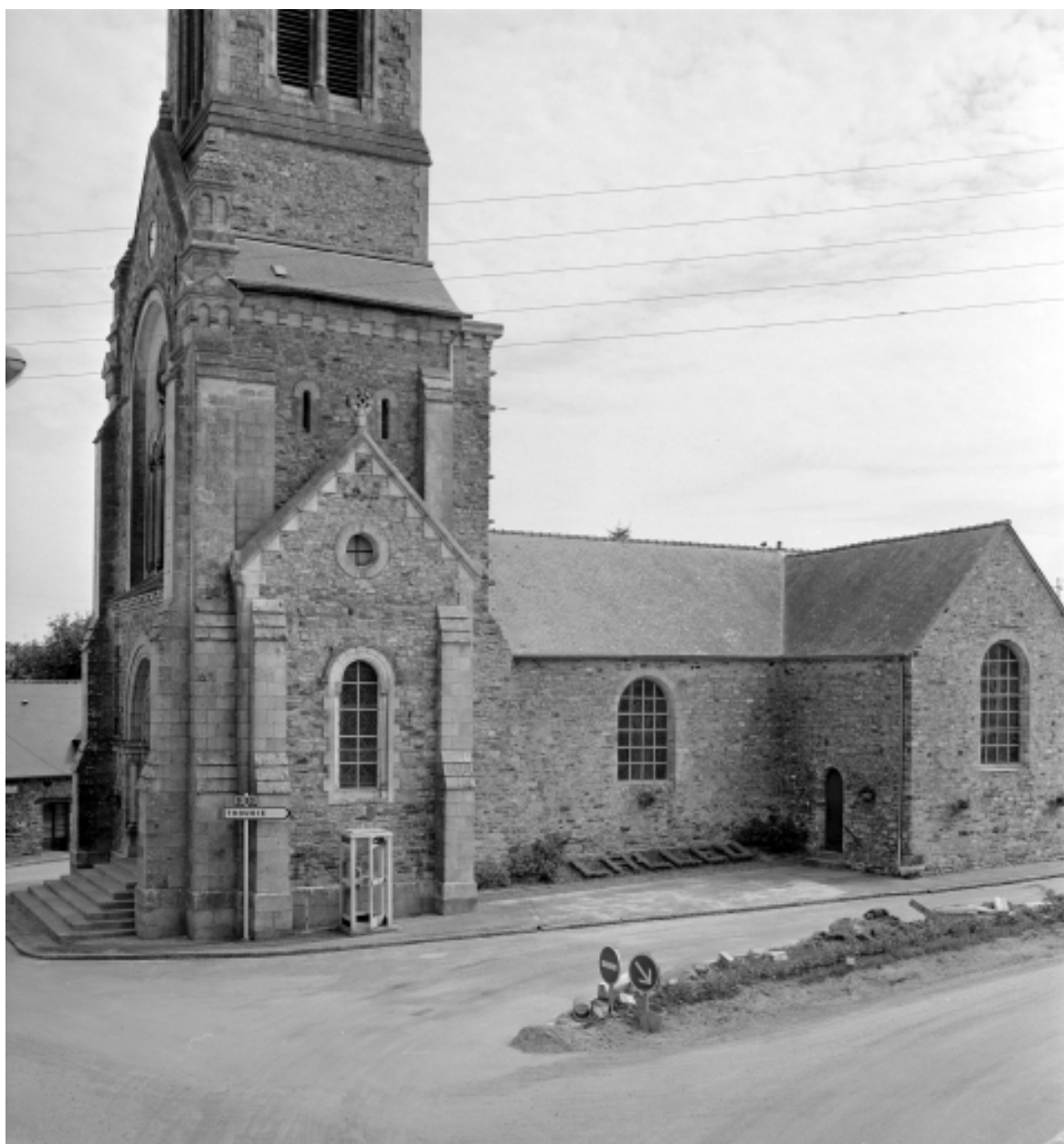
Elévation sud-ouest : vue générale
