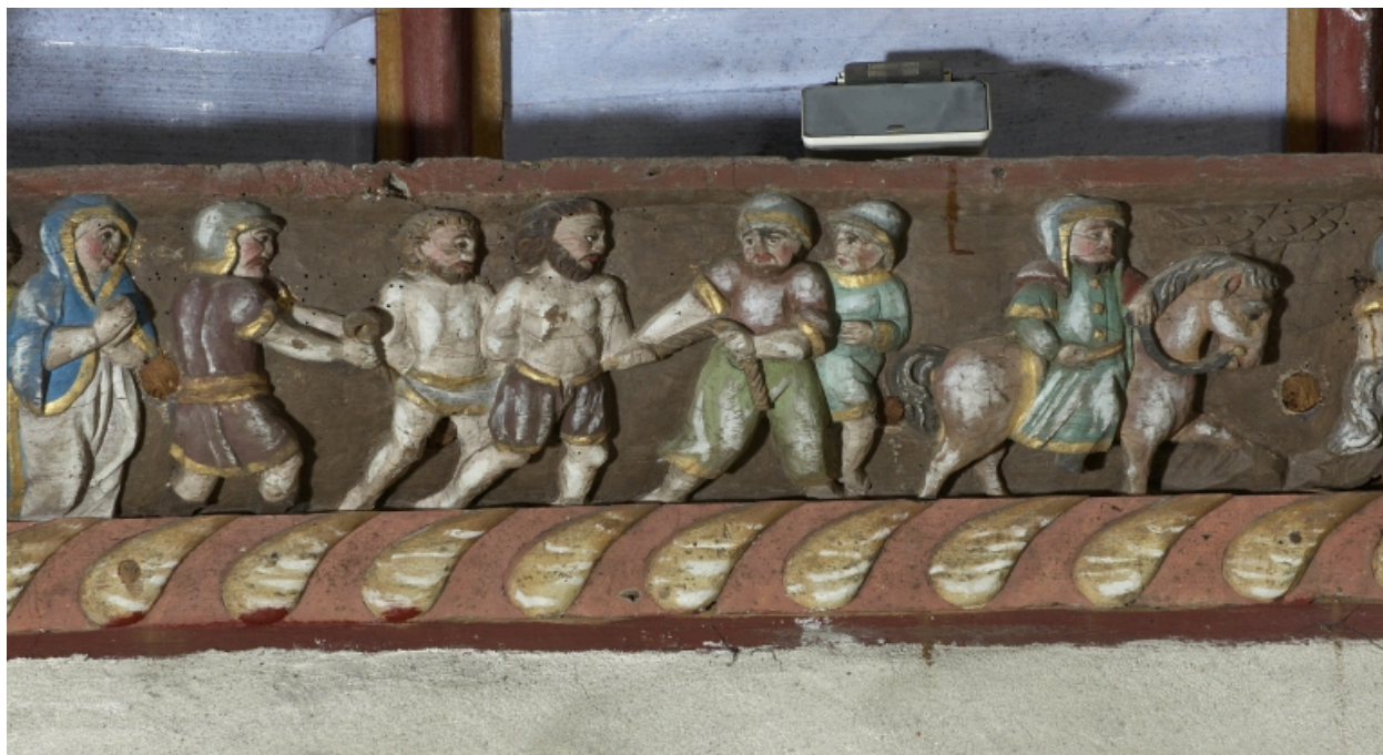
Intérieur, mur sud de la nef, détail de la sablière
