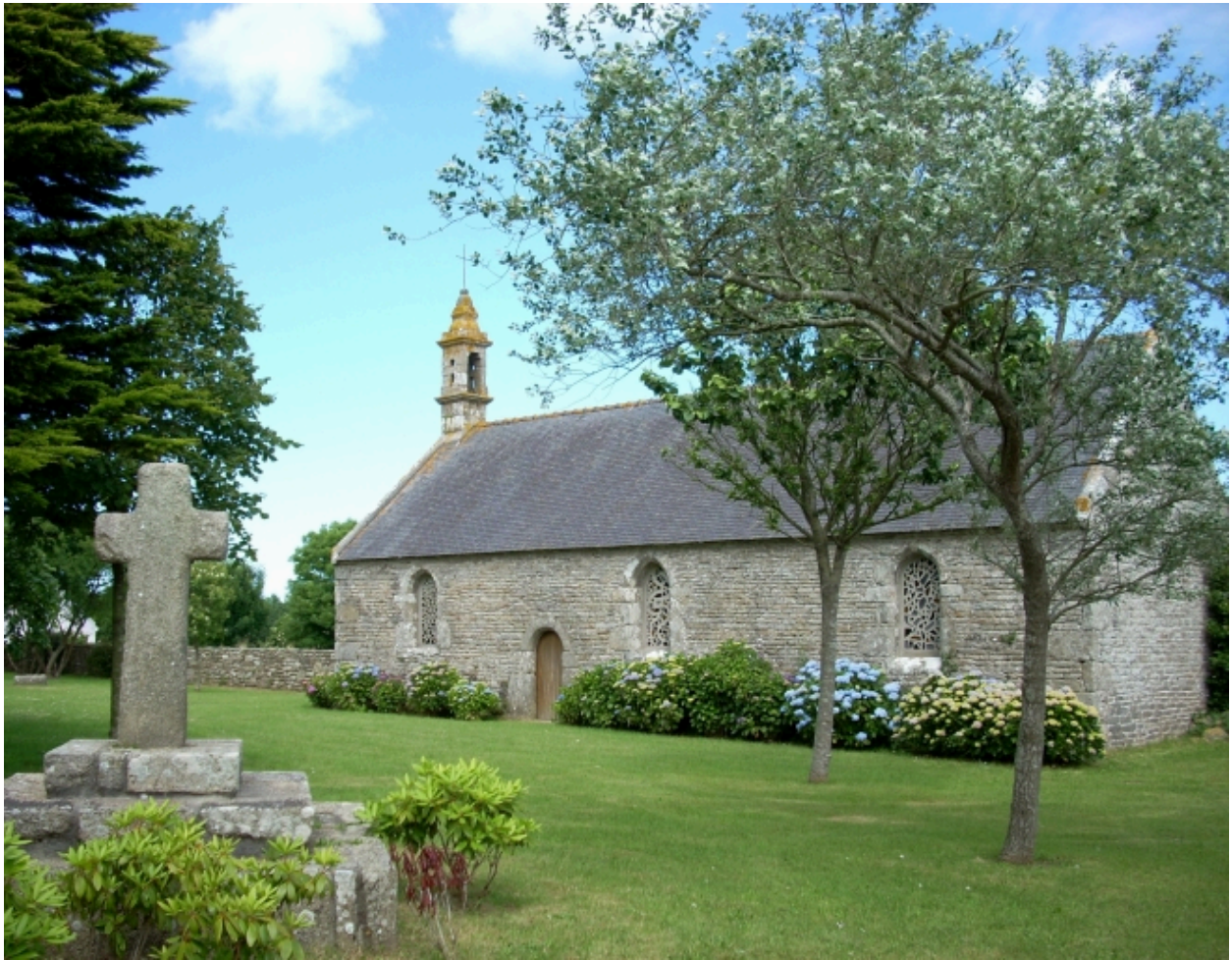
Ploudalmézeau, chapelle Saint-Roch : vue générale sud-est
