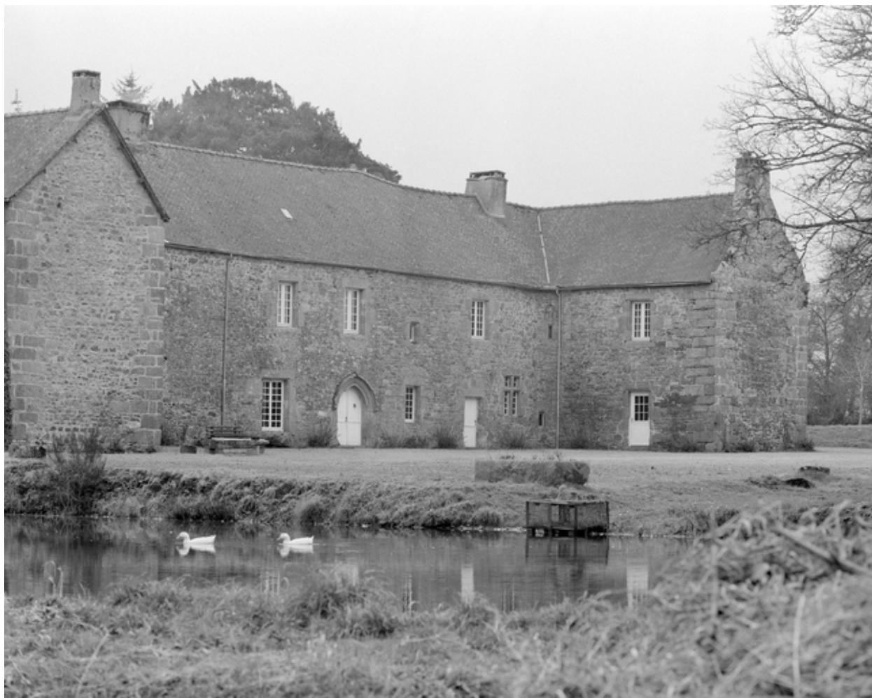
Logis : vue générale rapprochée prise du nord-ouest.
