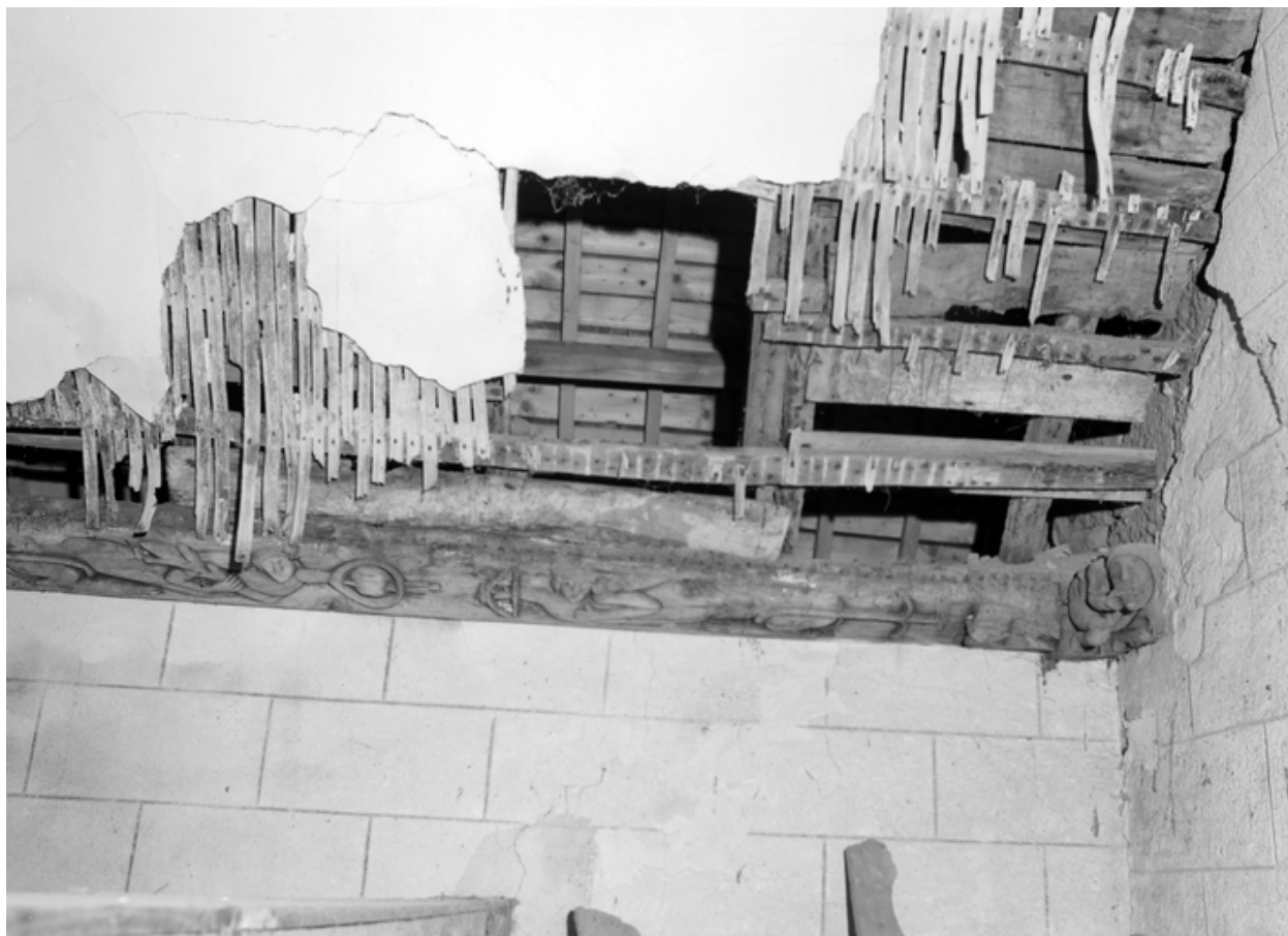
Sablières, mur sud.
