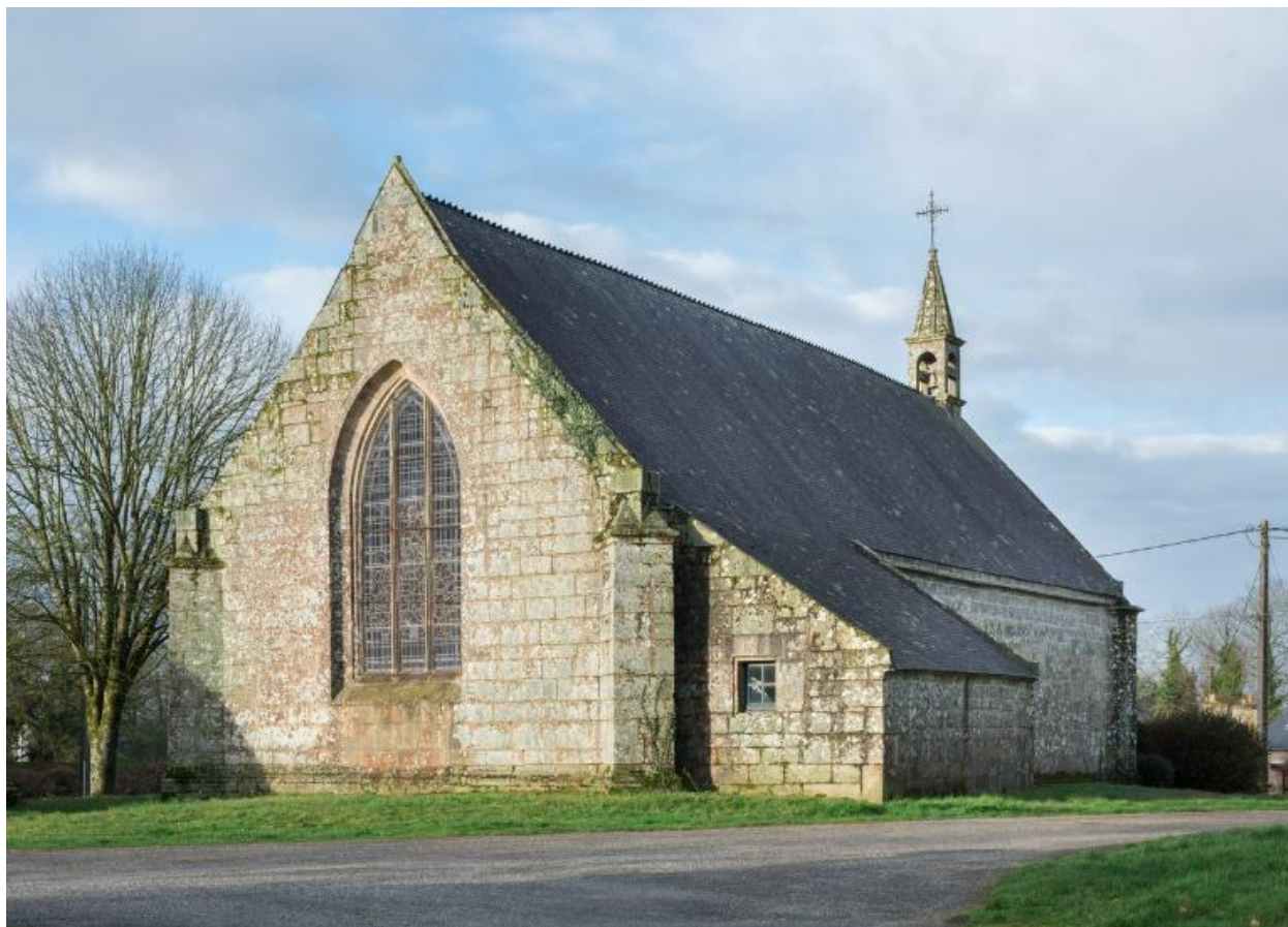
Vue depuis le nord-est
