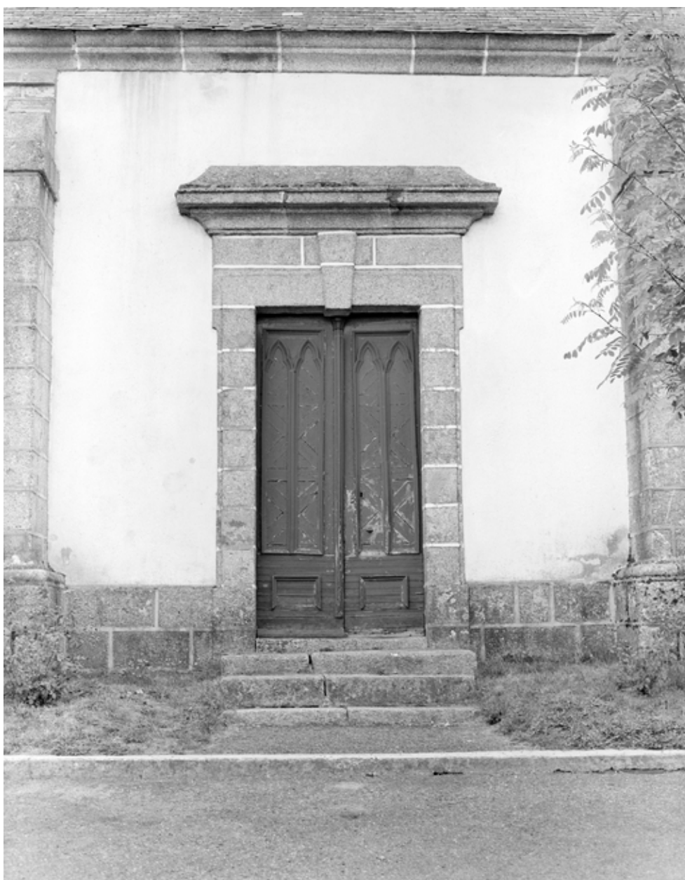
Nef, élévation sud : porte d'accès
