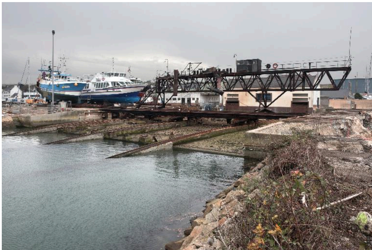
Slipway et passerelle
