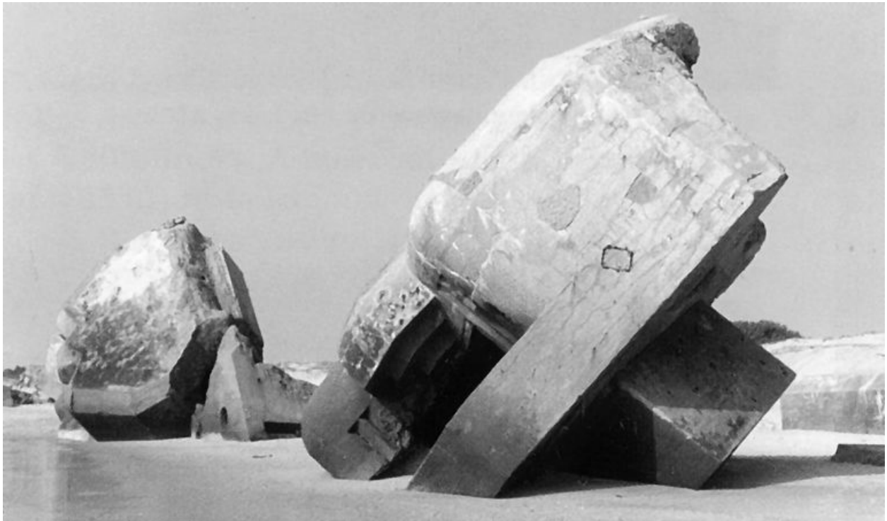
Vue générale de la batterie du Capbreton : casemates déchaussées
