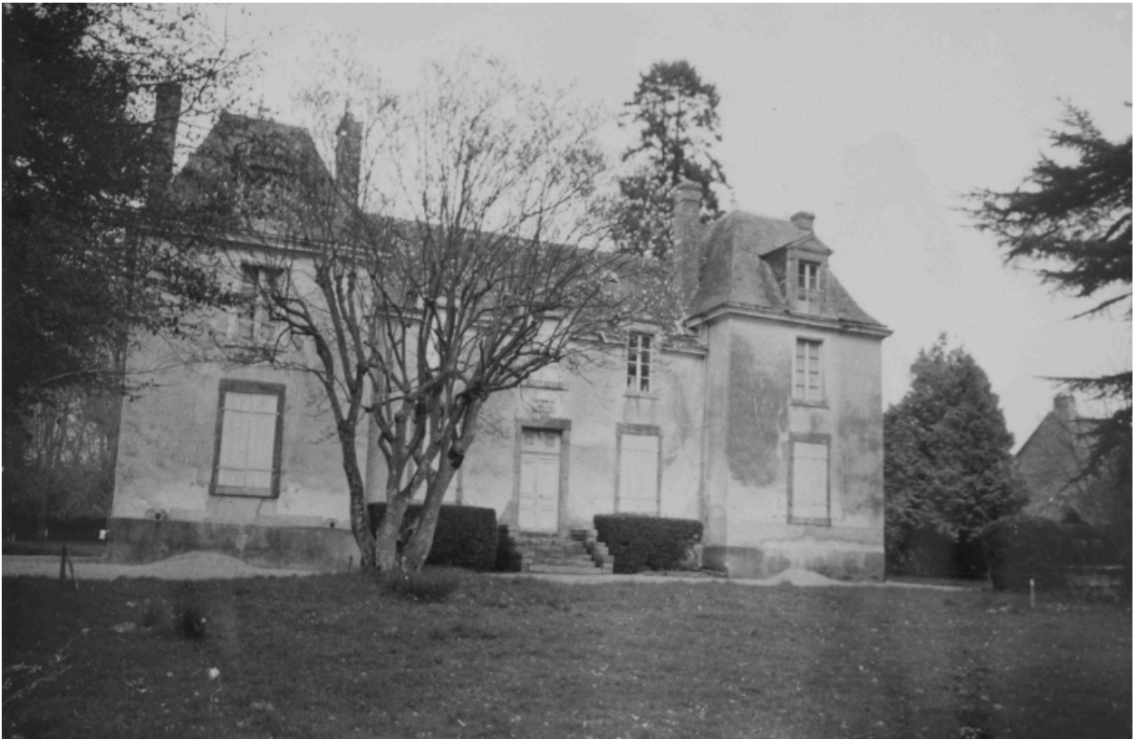
Vue générale de la façade (état en 1973)
