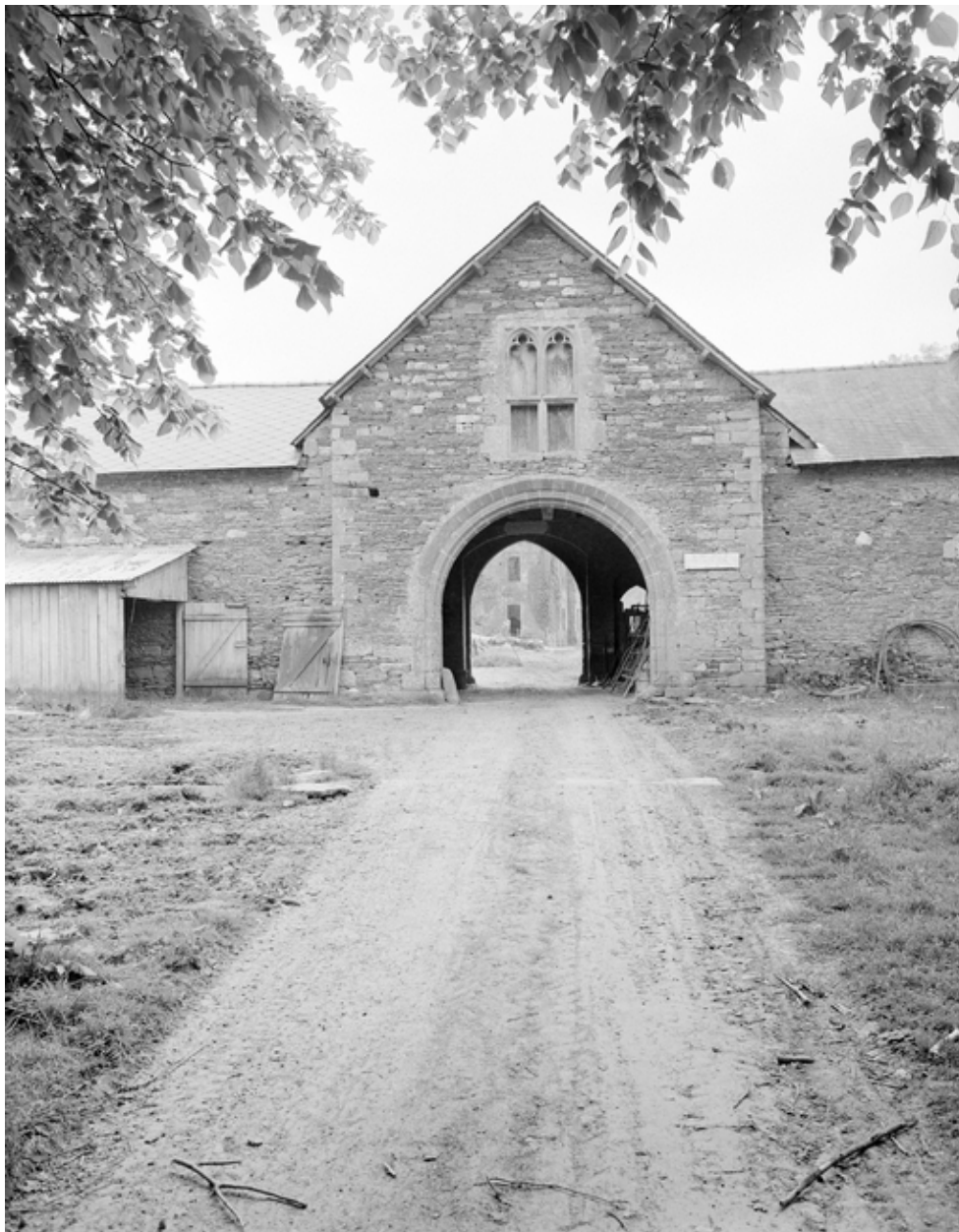
Portail d'entrée : vue extérieure prise de la rabine (état en 1977).
