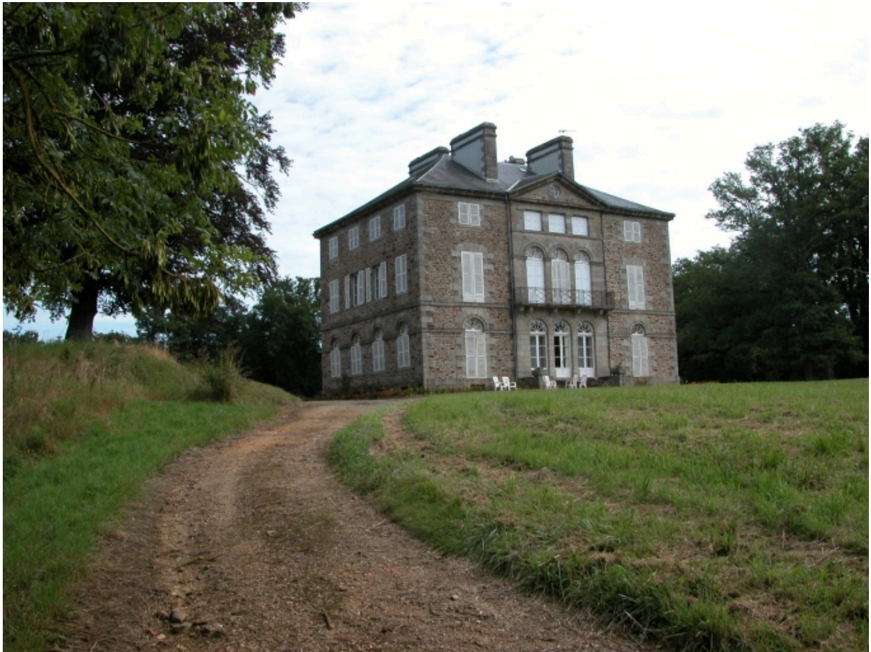
Château, vue générale sud
