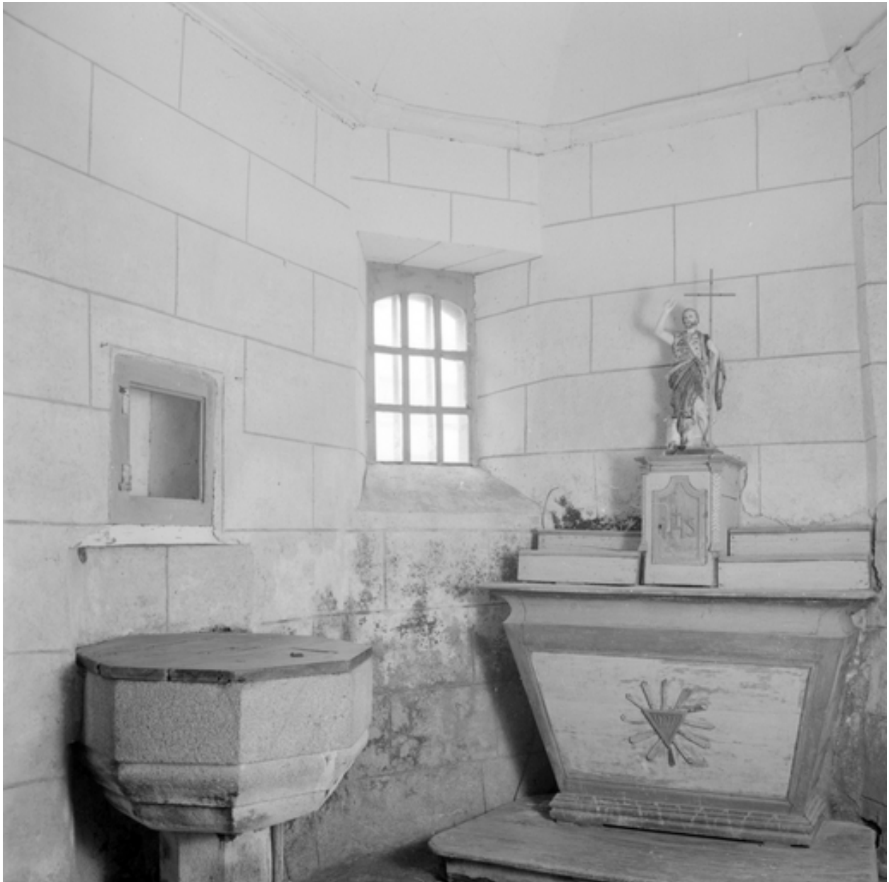
Chapelle des fonts baptismaux : vue axiale sud-nord
