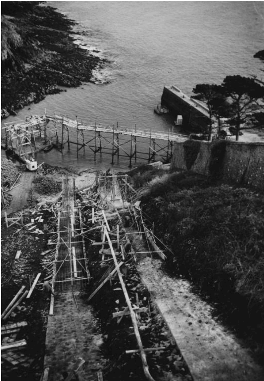
Vue de la rampe-funiculaire de la base d'essais de radiodétection en construction par les entreprises Dodin et Levoux, 3 janvier 1964 (collection : Service historique de la défense de Brest : 2 U 8, n° 96)
