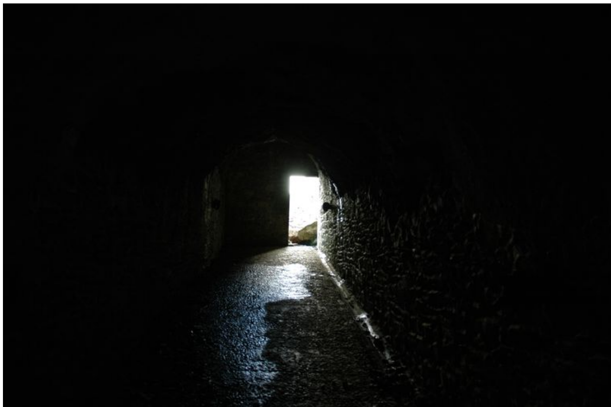
Vue de rampe d'accès depuis l'intérieur (état en 2005)
