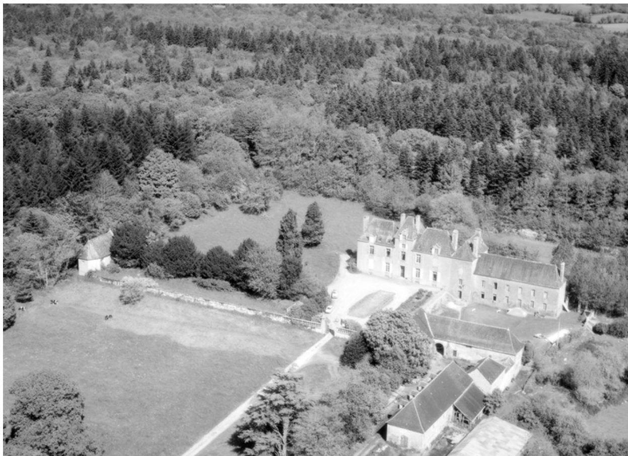
Vue aérienne prise du sud, état en 1969
