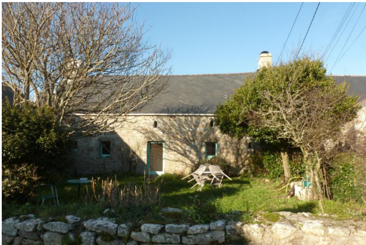
Maison 2, élévation antérieure du logis daté 1807.
