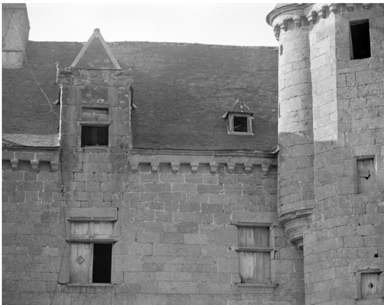
Face nord : corniche
