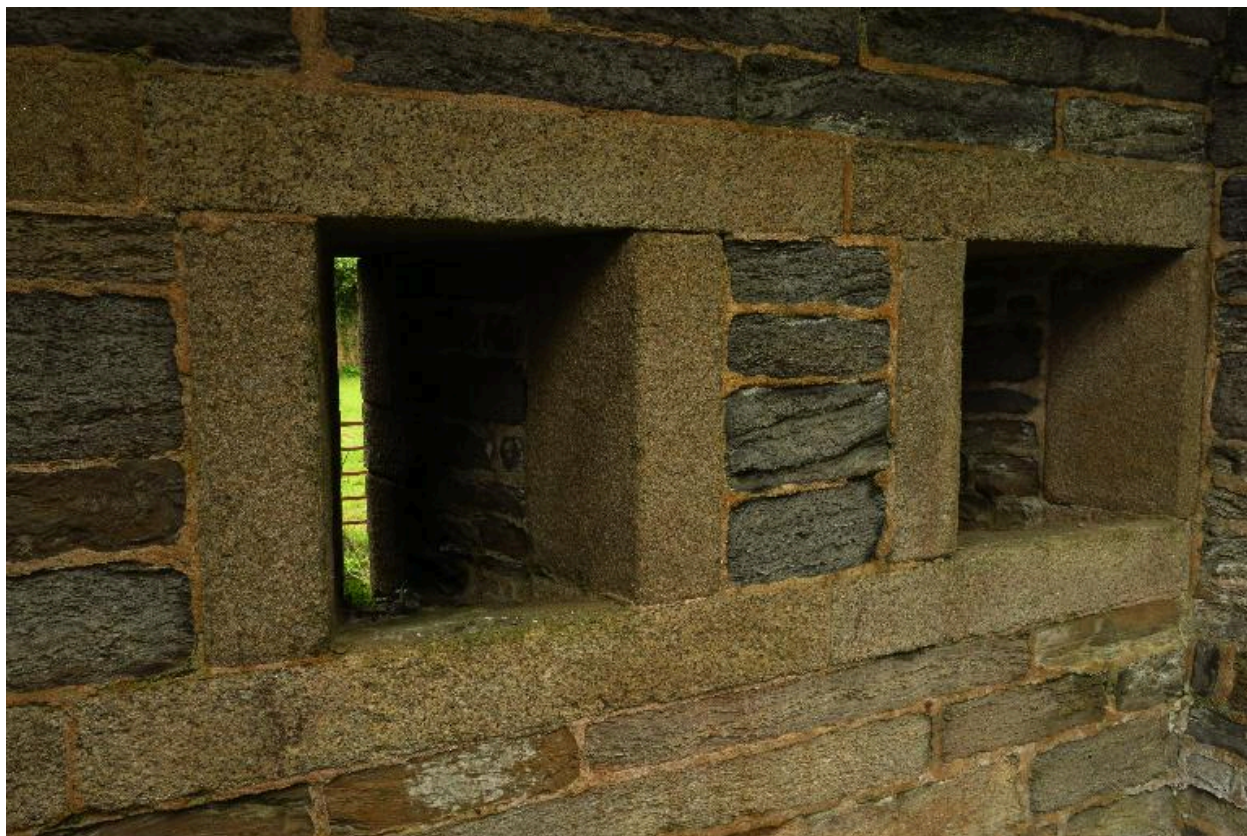
Le Palais, citadelle, haha, détail des créneaux de tir.
