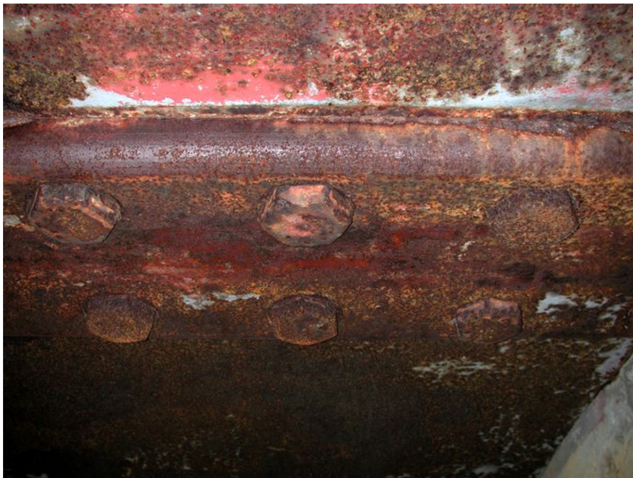
Vue du toit blindé (état en 2003)
