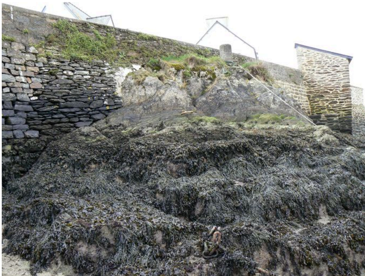
Perré entre le Quai de Kernabat et le Quai Neuf
