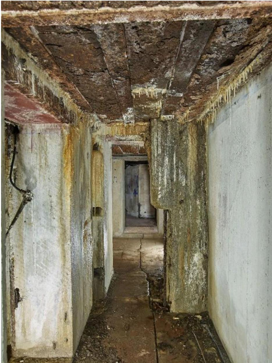
Vue du couloir desservant les chambres de combat nord-ouest et sud-ouest. Le mur en béton est élargi afin de permettre un passage plus aisé
