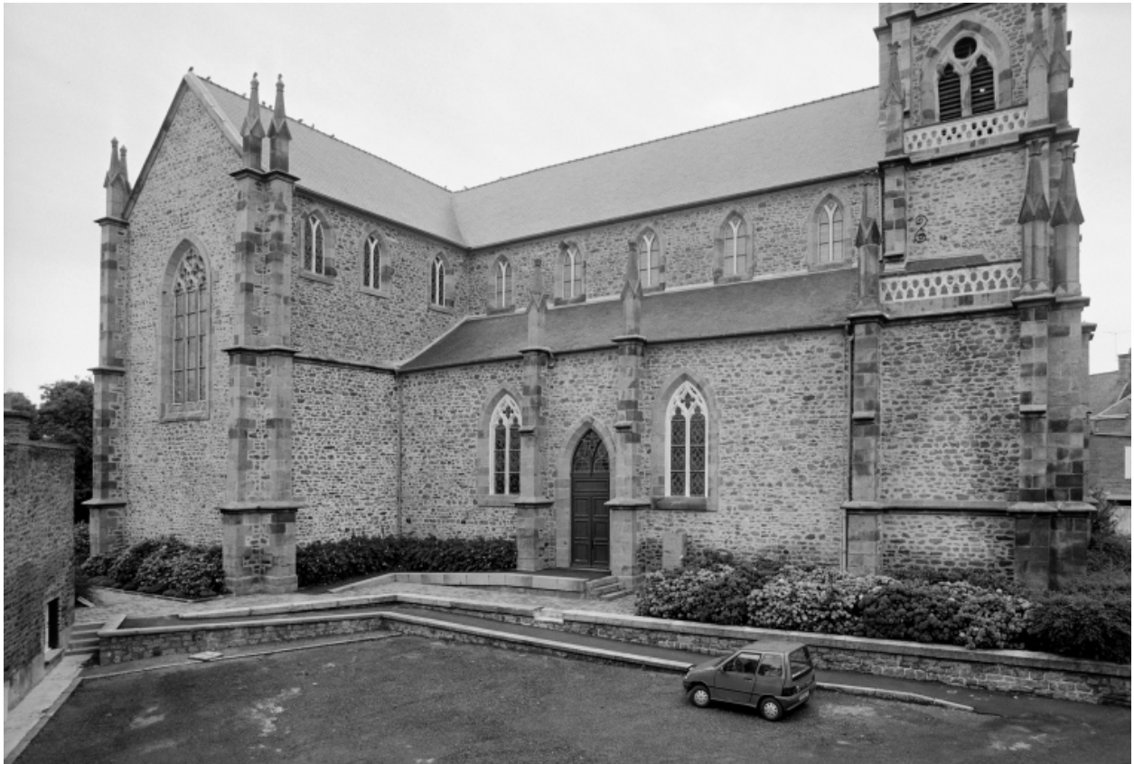
Elévation ouest, vue générale
