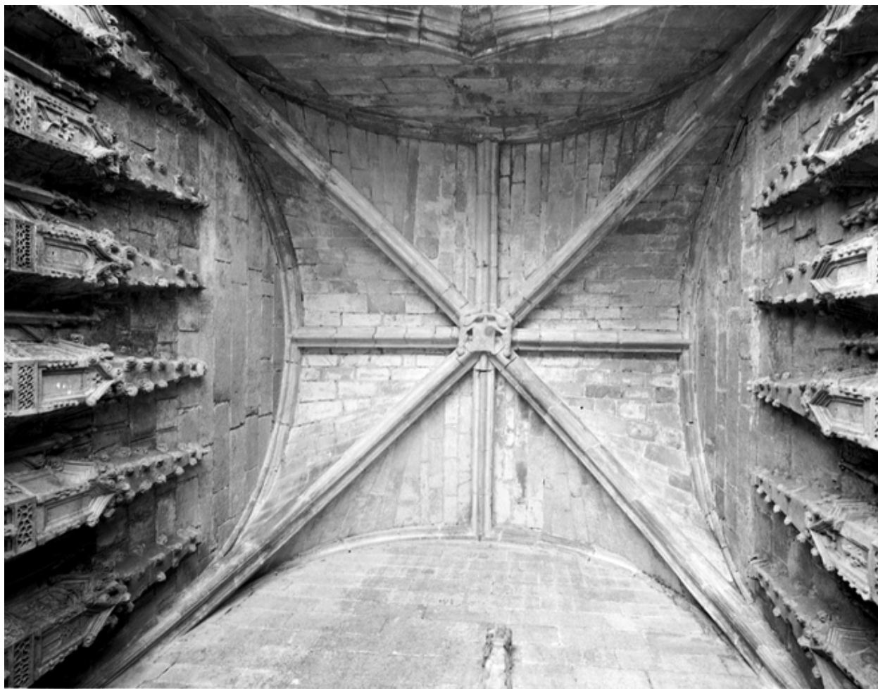
Porche sud : voûte
