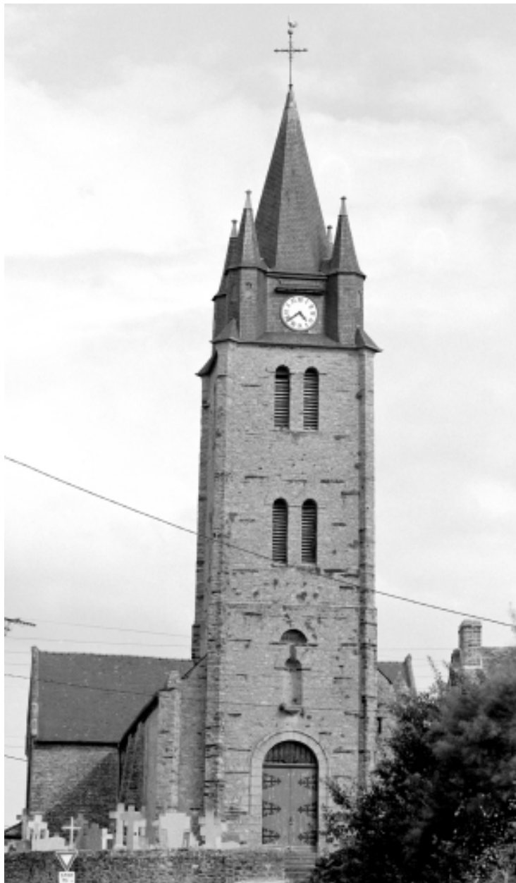
Elévation ouest, vue générale.
