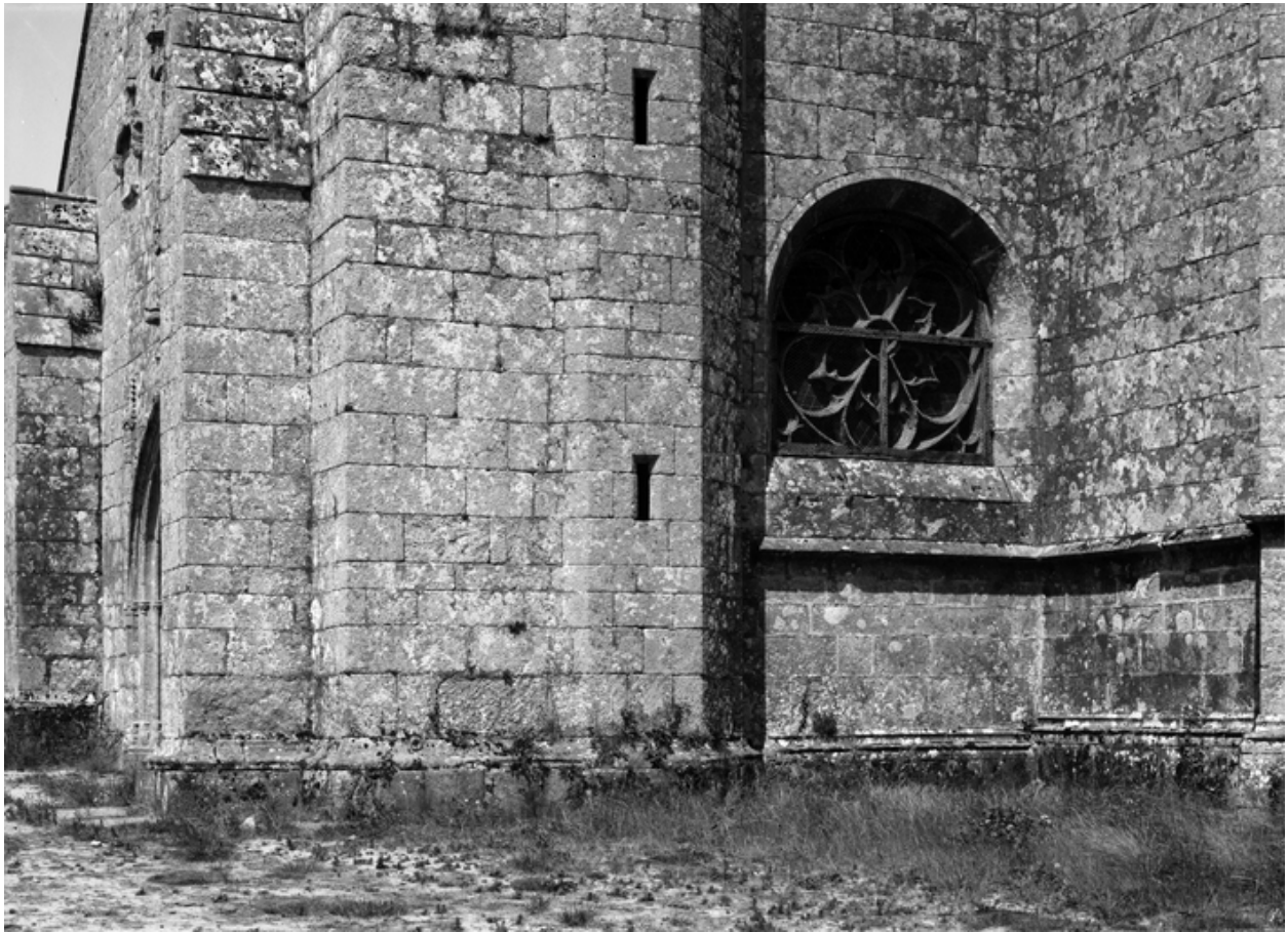
Partie ouest de la façade sud. Fenêtre avec rosace.
