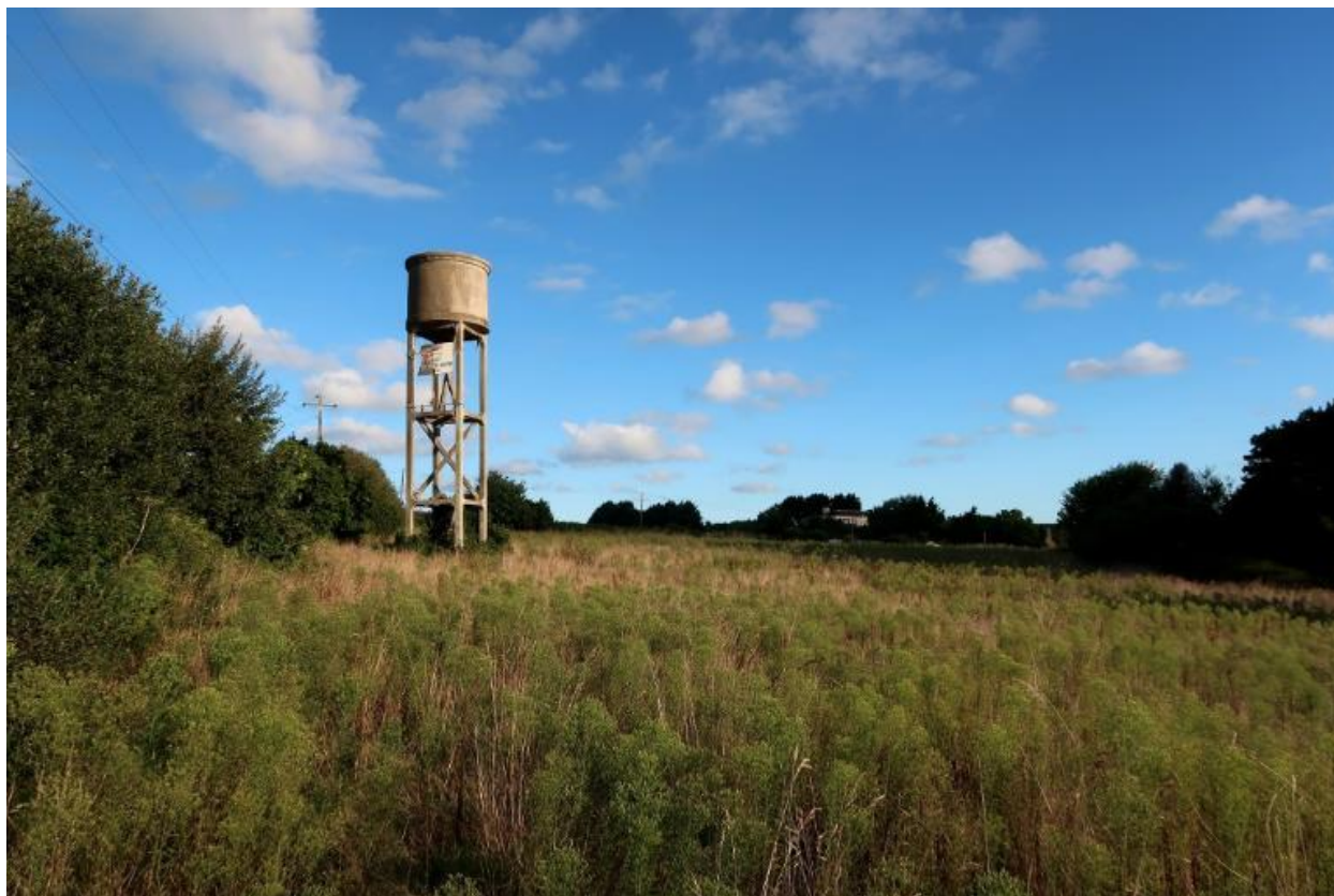
Vue générale depuis la route Saint-Yves au sud
