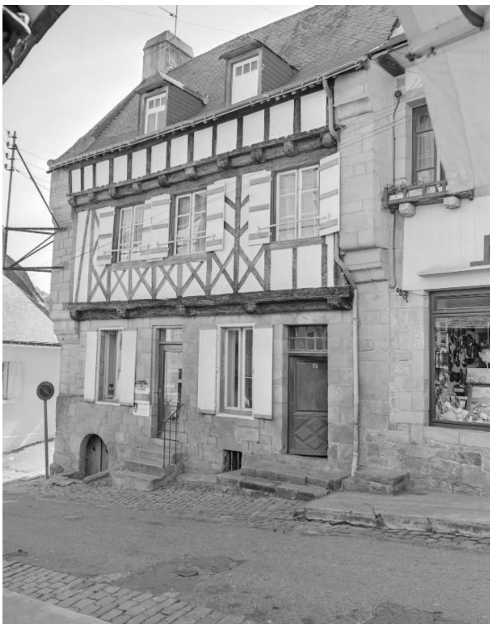
Façade gouttereau rue du Château.
