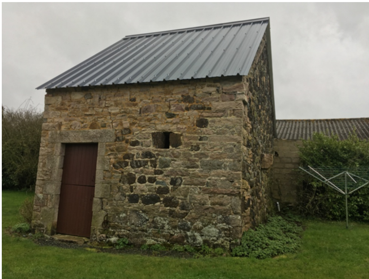
La Vieille Moinerie, vue nord
