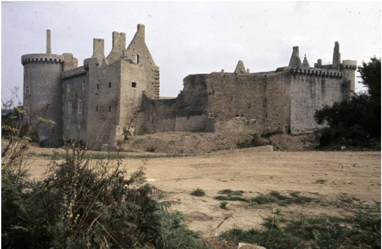
Château fort : vue générale sud-ouest
