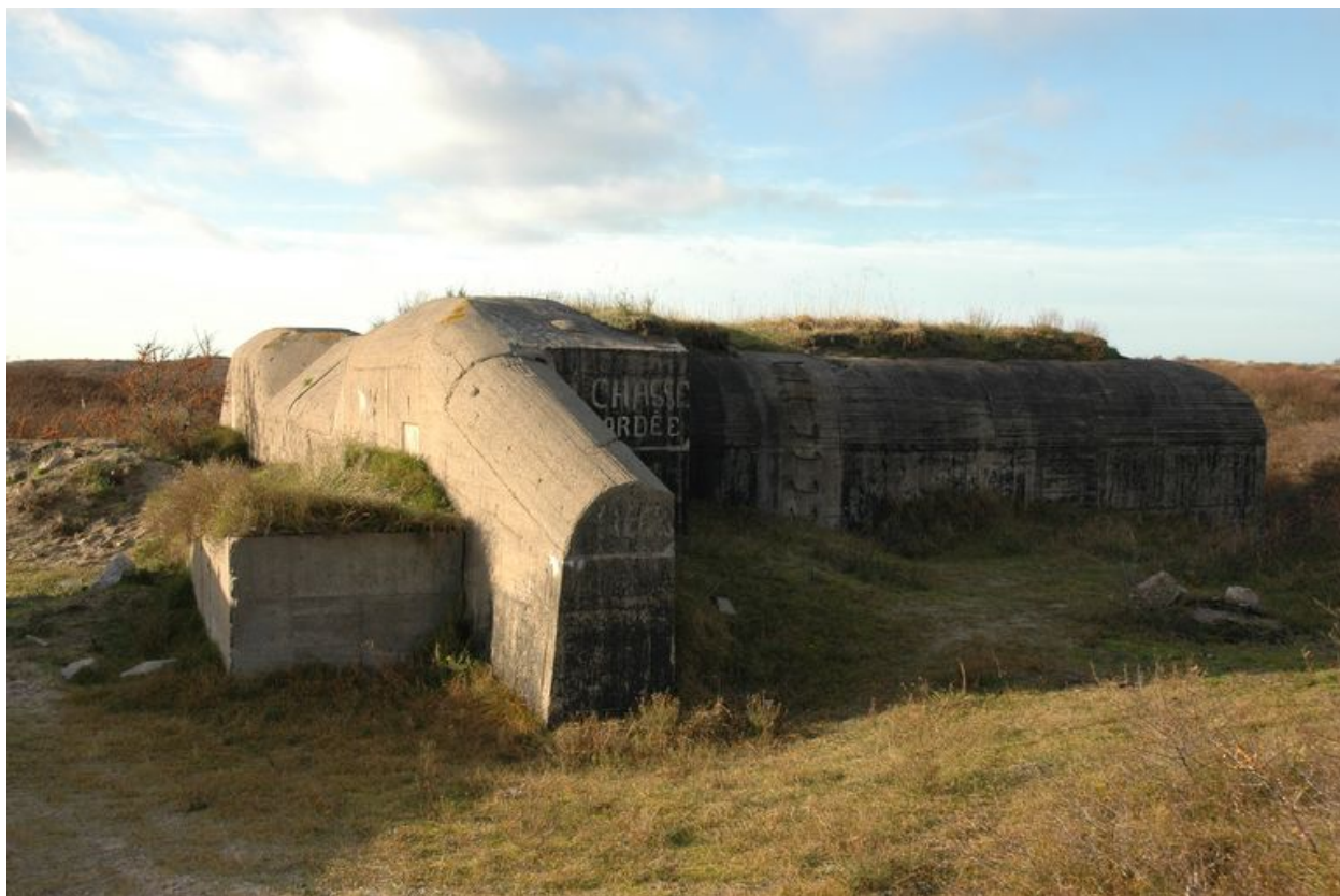
Pas-de-Calais : vue d'un abri de la batterie Oldenburg dite batterie du Moulin Rouge
