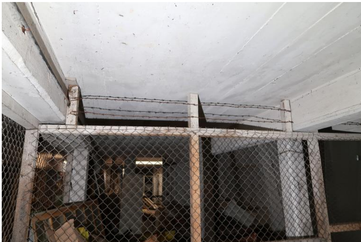
Premier étage : grillage surmonté de deux rangs de fil barbelé séparant deux boxes
