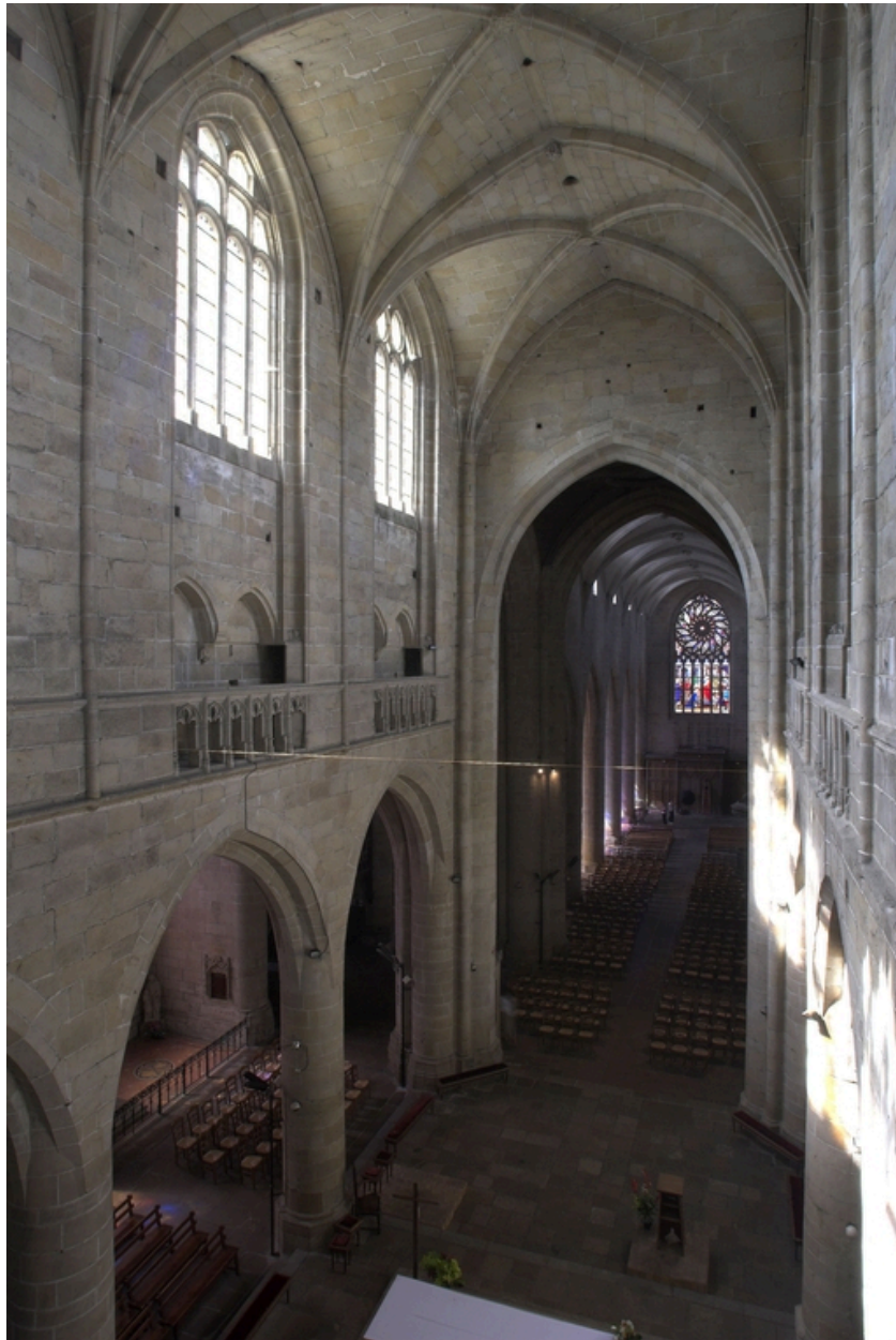
Du chœur vers la nef, depuis le triforium
