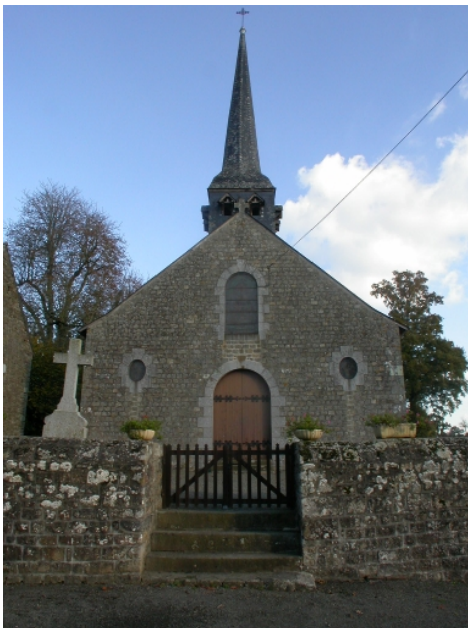
Vue de l'entrée de l'église
