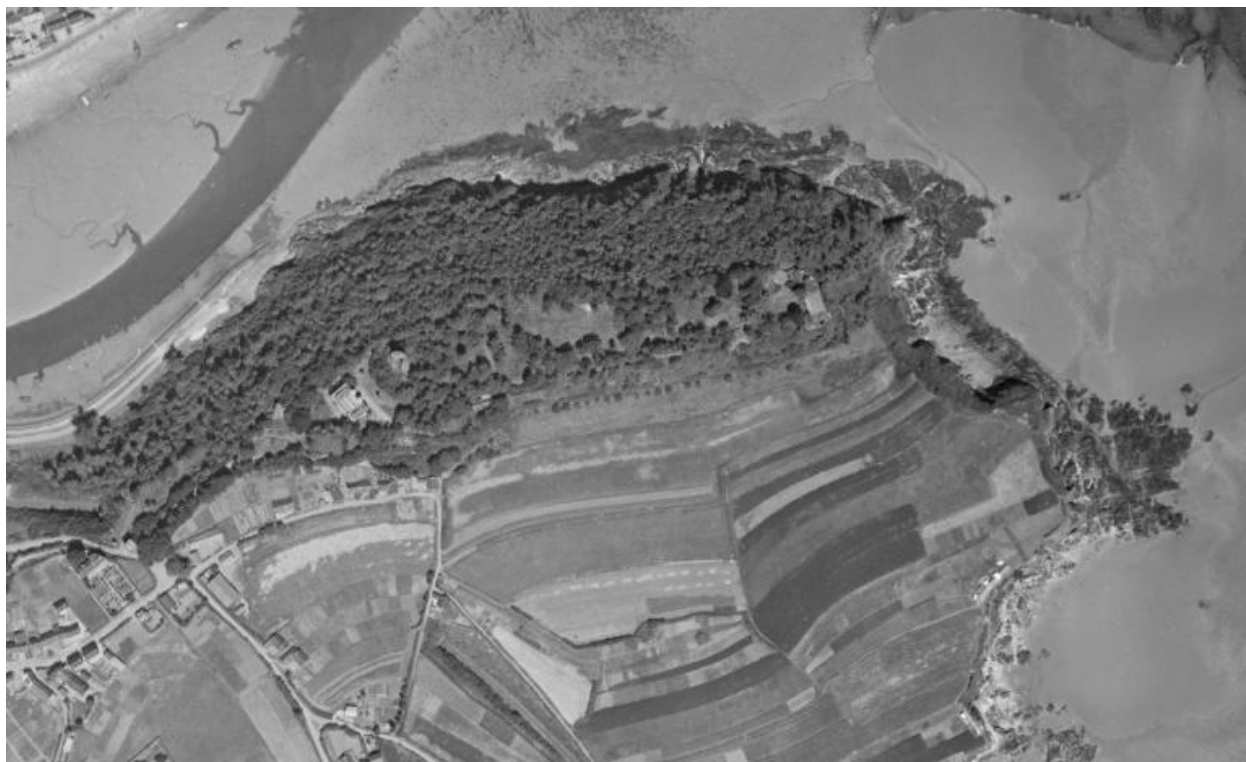
Vue aérienne de la pointe de Cesson avant la construction du polder du port de commerce du Légué (15/07/1951)
