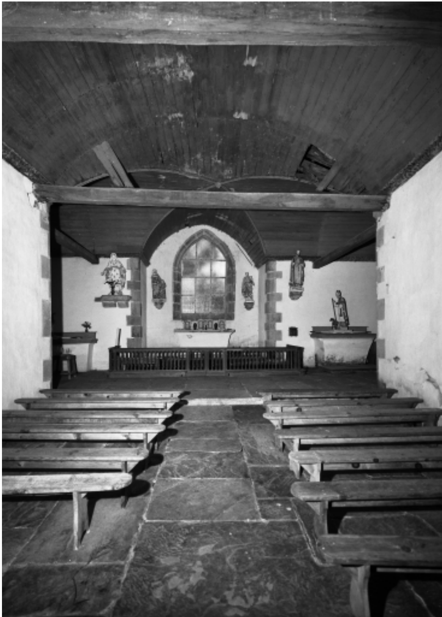
Saint-Thois, chapelle Saint-Laurent : vue générale intérieure vers l'est, état en 1966
