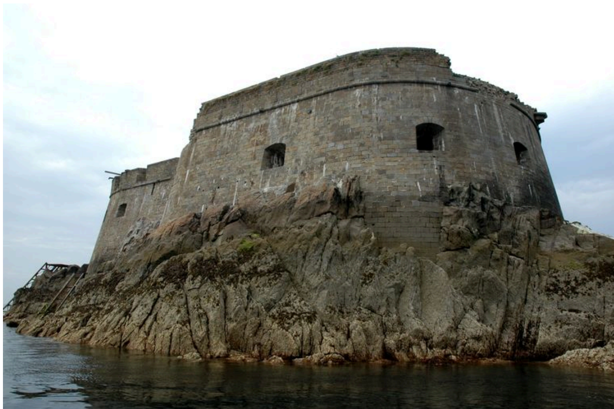
Vue générale du fort de la Conchée
