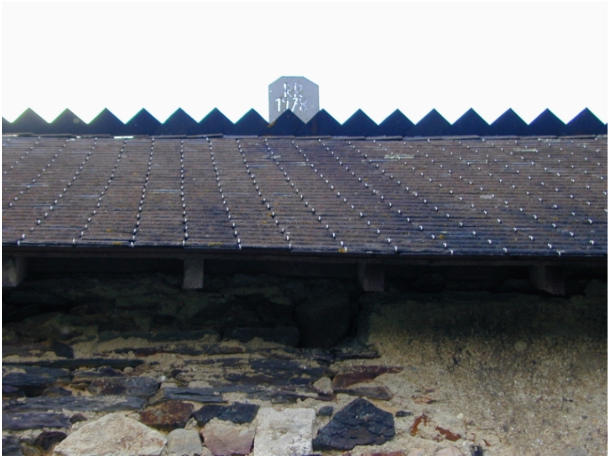
Ardoise portant la date de la réfection de la toiture : détail
