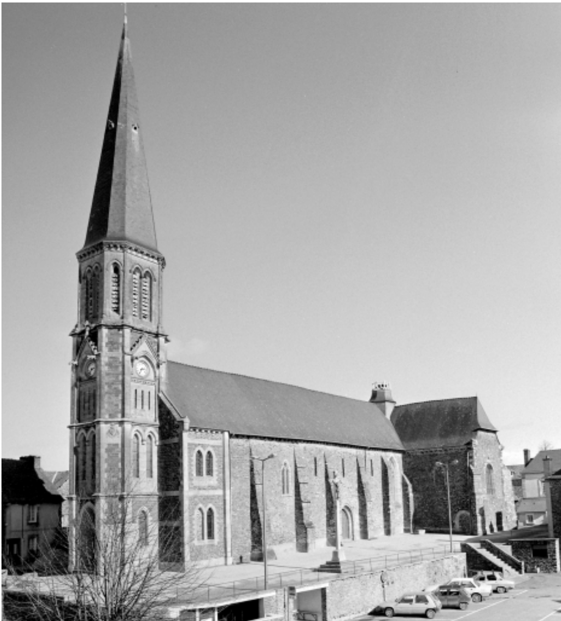
Elévation Sud-Ouest : vue générale
