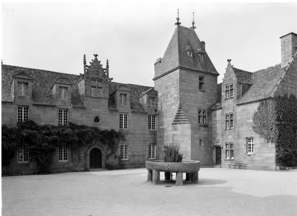
Tour d'angle et façade est
