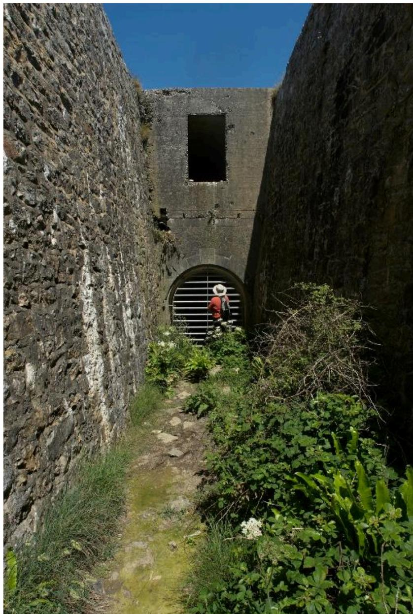
Vue de l'entrée en arc plein cintre du magasin à poudre sous roc de la batterie de mortier.
