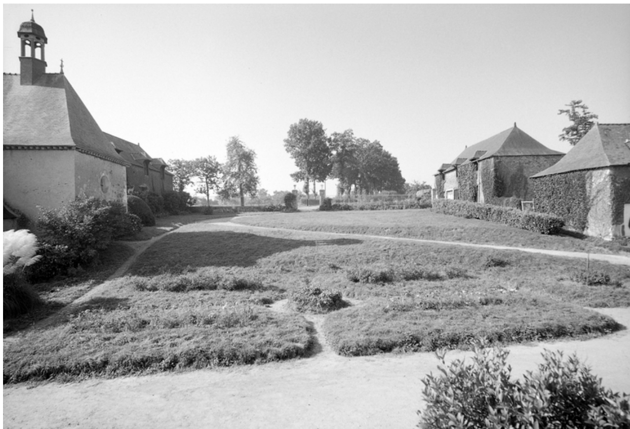
Cour intérieure, vue générale est ouest.
